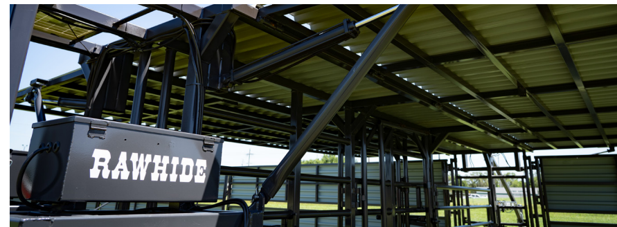
Techo con tirantes desde el exterior
